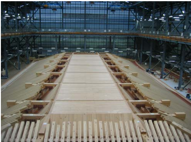
第一層の天井
