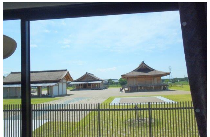
斎宮があったとされる場所に復元された建物(車窓より)
