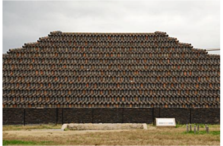
全面に瓦が葺かれている。基壇の上には12層の壇がピラミッド状に土で築かれ、それを全て瓦で覆っている
