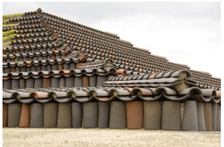
瓦はご覧の通り各段の上だけでなく縦面にも葺き風雨から土壇を守る構造となっている
