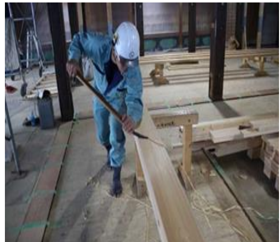
古式の木工技術による修理の様子
