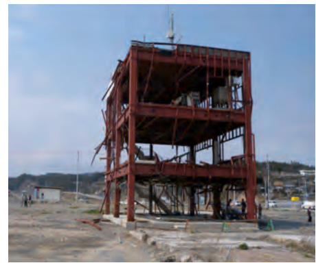
防災センター
