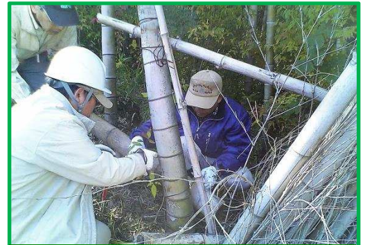
横棧を固定する生きた竹の周りを整備。
