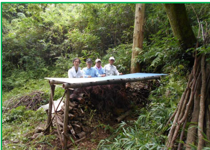
柱はクロス筋交いで補強していますから、ガッチリ固定出来ています。
