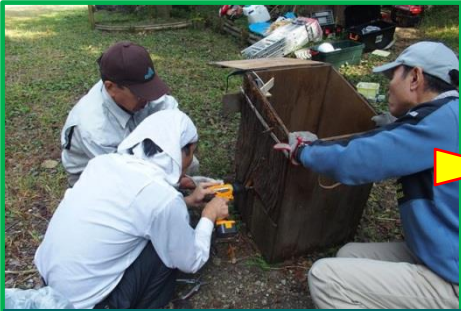
まずドリルで穴をあけ・・・
