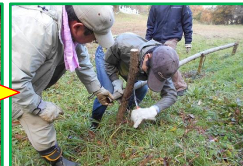
杭と横の竹を番線で止めて完了です。
