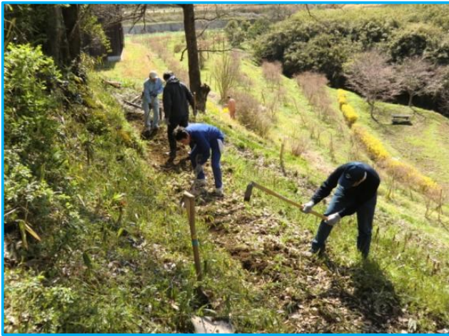
(歩道の拡幅作業をしました。)
