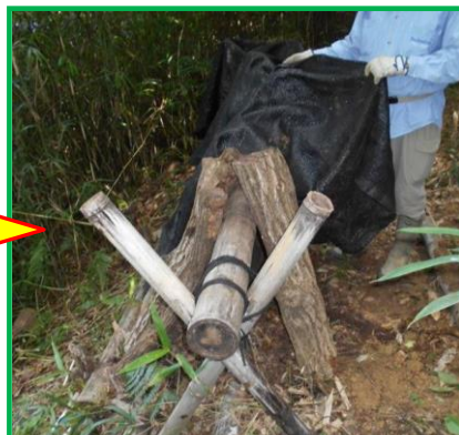
棕櫚縄で支えを組み直し、修理完了。
