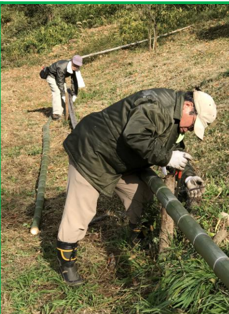
杭を打ち直し、シノを使って番線で竹と杭を固定。
