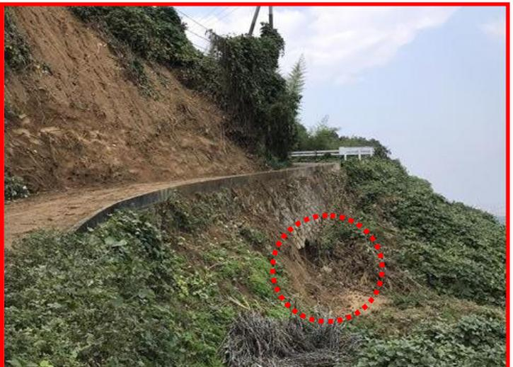
土砂崩れの現場 円の部分の護岸の石が流れている。
