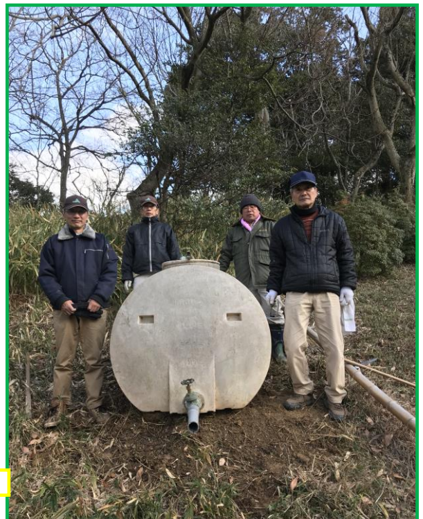
貯水槽設置完了。今日の作業も完了。
