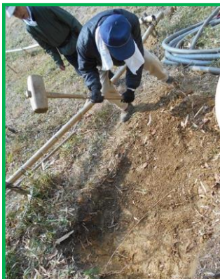
貯水槽の設置場所の基礎を固め、杭を打って固定しました。
