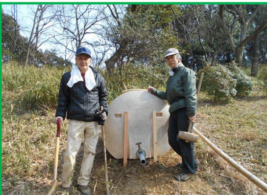
貯水槽の設置場所の基礎を固め、杭を打って固定しました。
