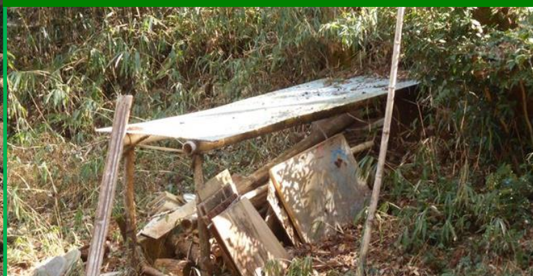
薪置き場の波板屋根。もう一列増やして取水します。
