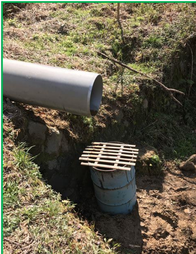
17日に設置した暗渠の雨水収集装置
