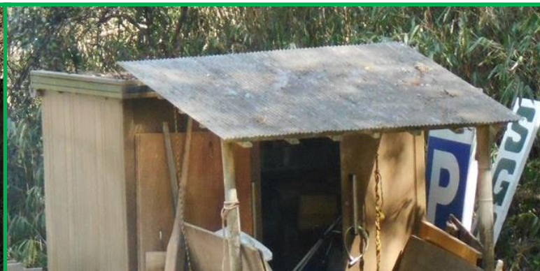
倉庫の波板屋根。トコを付ければすぐ取水できます。
