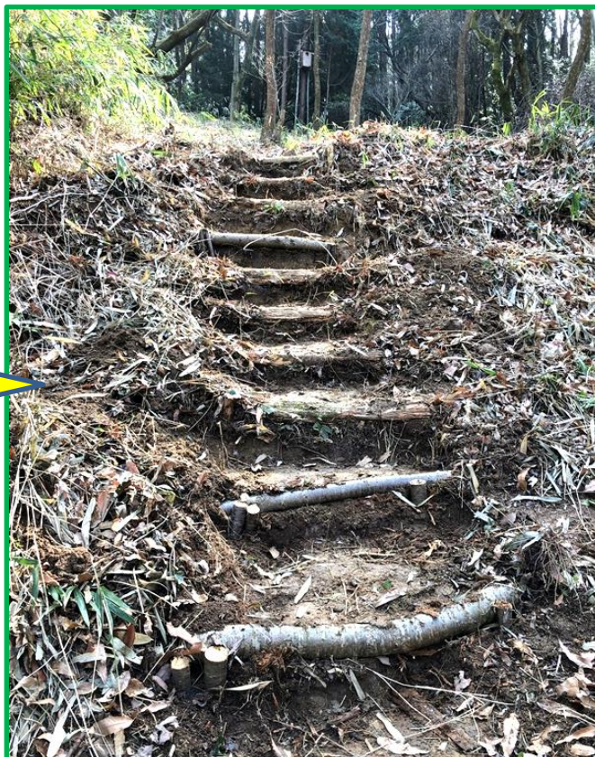
腐食した横木を取り換え、杭で固定して修復完了。
