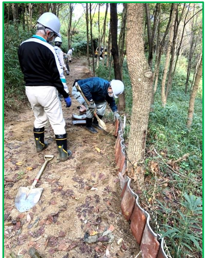
奥近くの補強箇所（奥から入口に向かって撮影）
