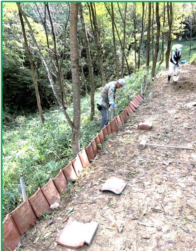
入口から少し入った補強箇所（入口方向から撮影）
