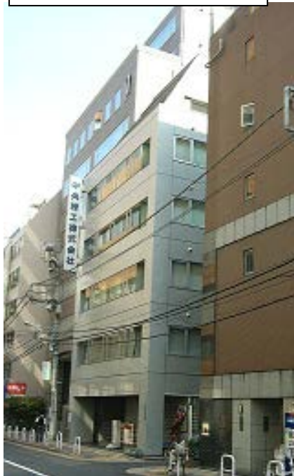
旧オフィスのあったビル
