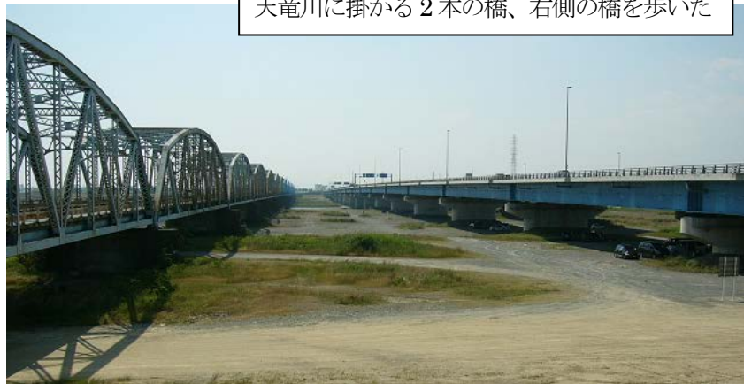
天竜川に掛かる2本の橋、右側の橋を歩いた
