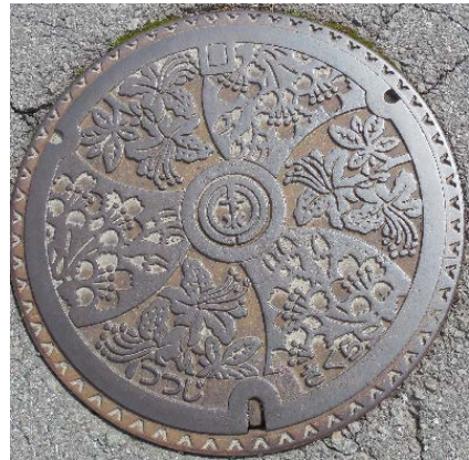
下諏訪のマンホールの蓋
