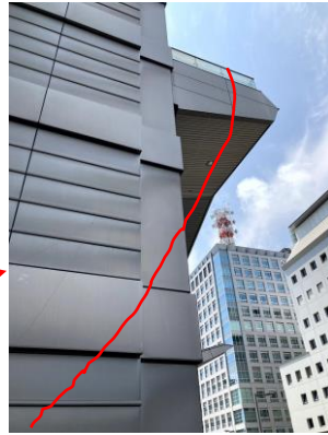
4階くらいの高さのテラスからワイヤを下した
