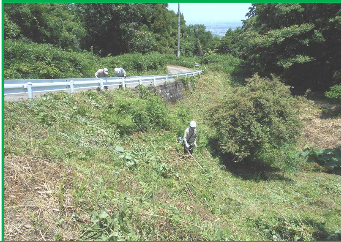
林道のガードレール沿いも丹念に刈り込みました。
