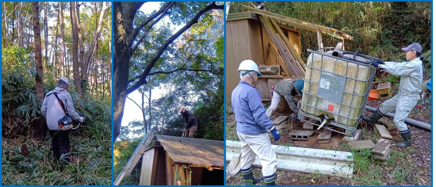
左）上部植栽地の草刈り 中）倉庫の屋根に積もった枯葉を掃除 右）水槽の下の土とブロックを入れ直しました。
